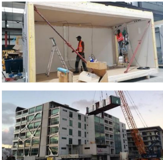
Figure 5. Construction hors site de l'usine au chantier © Aurenche, Eric, 2020.
