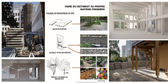
Figure 32. Opération de réemploi in situ des planchers béton en dallage de l'espace public sur la médiathèque Jean Quarré © Madec, Philippe, 8-12 avril 2024.
