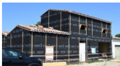
Figure 19. Procédé de fabrication d'une maison individuelle avec la technologie Terlian®.
