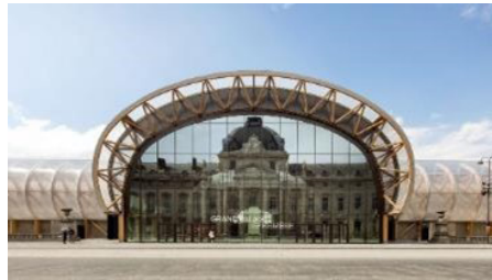
Figure 25. The Grand Palais Éphémère built using a wooden structure © Jean-Michel Wilmotte & Associés, 2021
