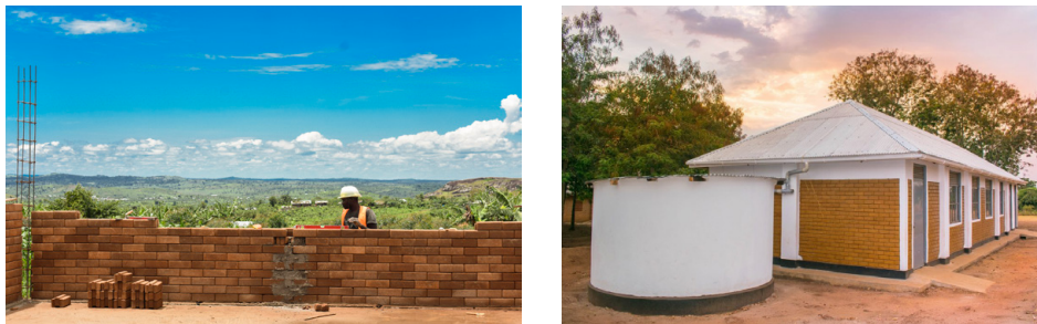
Figure 17. Construction d'une école à partir des blocs ISSB © Nambatya, Mauricia. 8-12 avril 2024.
