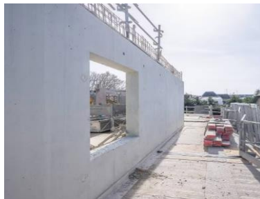
Figure 24. Façade en béton prêt à l'emploi en ciment 0 % de clinker © Fabre, Maël, Ouest-France, 24 avril 2024.
