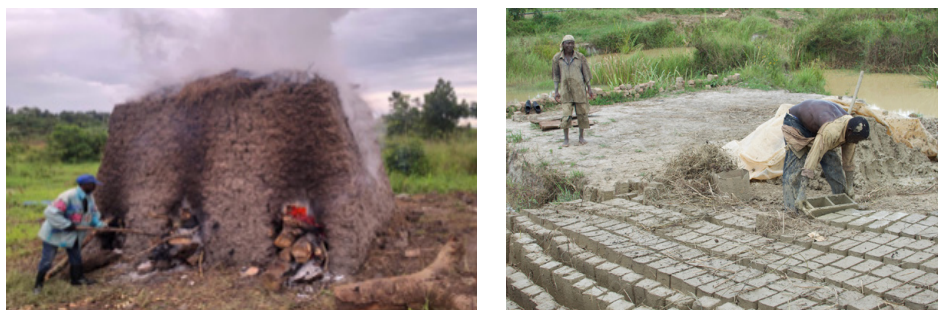
Figure 13. Méthode de fabrication traditionnelle des briques en Ouganda © Nambatya, Mauricia. 8-12 avril 2024.
