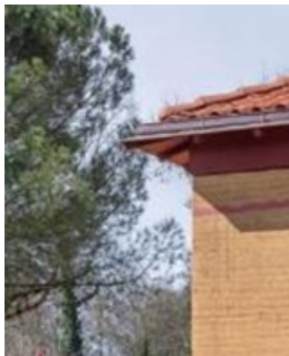
Figure 17. Murs en pisé, Cantenac Brown
